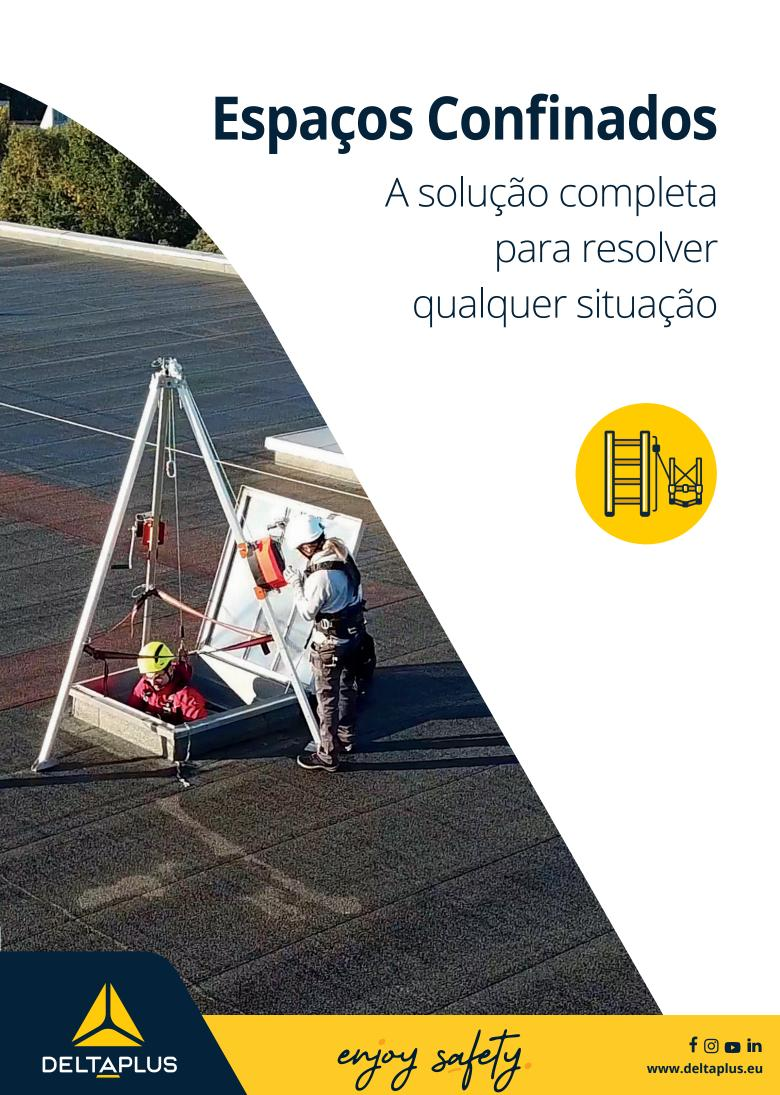
O nosso dispositivo anti quedas automático TR01820U ou TR01830U permite-lhe garantir com segurança acesso (escada, estrutura, pedais) ou sem acesso utilizando a técnica de trabalho de corda.
