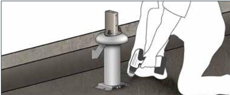
3 - Les embases sabot D sans manchon d'étanchéité sont livrées prémontées. Fixez les sabots D sur la dalle tous les 1500 mm maximum selon préconisations avec chevilles chimiques M10 Chimfort KEM H M10 ou chevilles mécaniques du type Baraco crack FM 75 M10.
